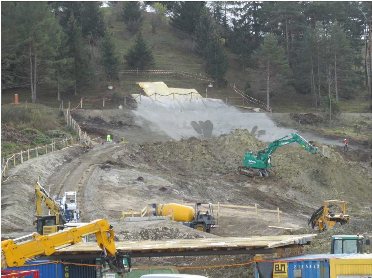
31.10.2018 Baugeschehen am Voreinschnitt Nordportal, Böschungssicherung mit Spritzbeton (Autobahndirektion Südbayern)
