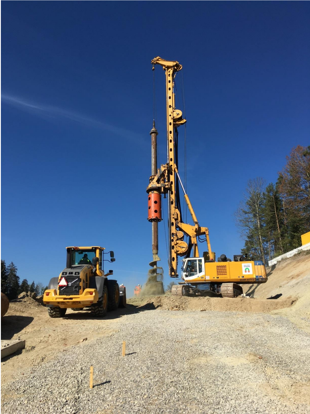
Bohrpfahlarbeiten am Südportal Tunnel Bertoldshofen (Ralf Eisele, Staatliches Bauamt Kempten)
