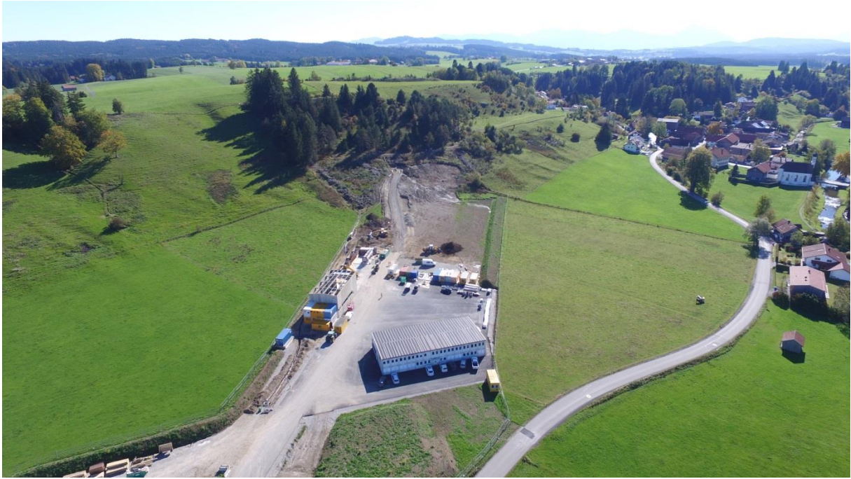
31.10.2018 Voreinschnitt Nordportal (Staatliches Bauamt Kempten)
