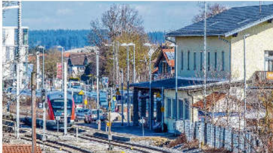
Das Projekt Bahnhofsanbau in Marktoberdorf soll Ende 2019 abgeschlossen sein, sagt ein Vertreter der Bayerischen Eisenbahngesellschaft.
