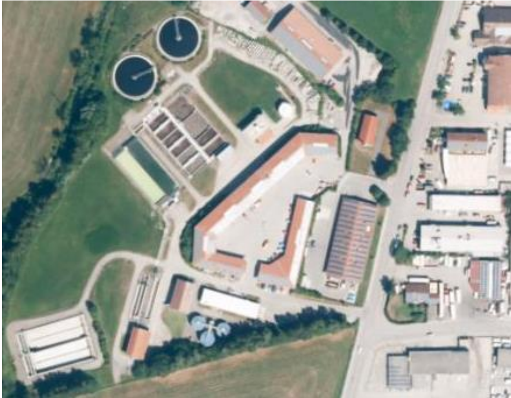
Abbildung 3-2: Lage der Kläranlage (Luftbild)
