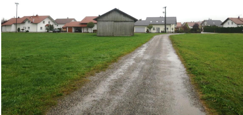
Bild A04: Bestandsbebauung im Bereich der Umwidmung
