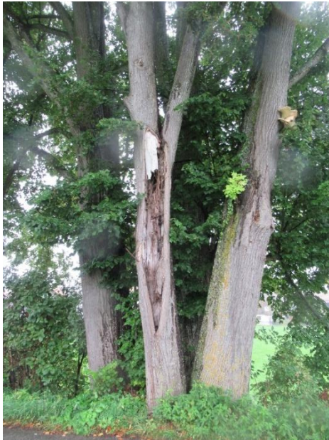
Abb. 10 Straßenseitige Stammschäden am Naturdenkmal; eigene Aufnahme vom 16.09.2024
